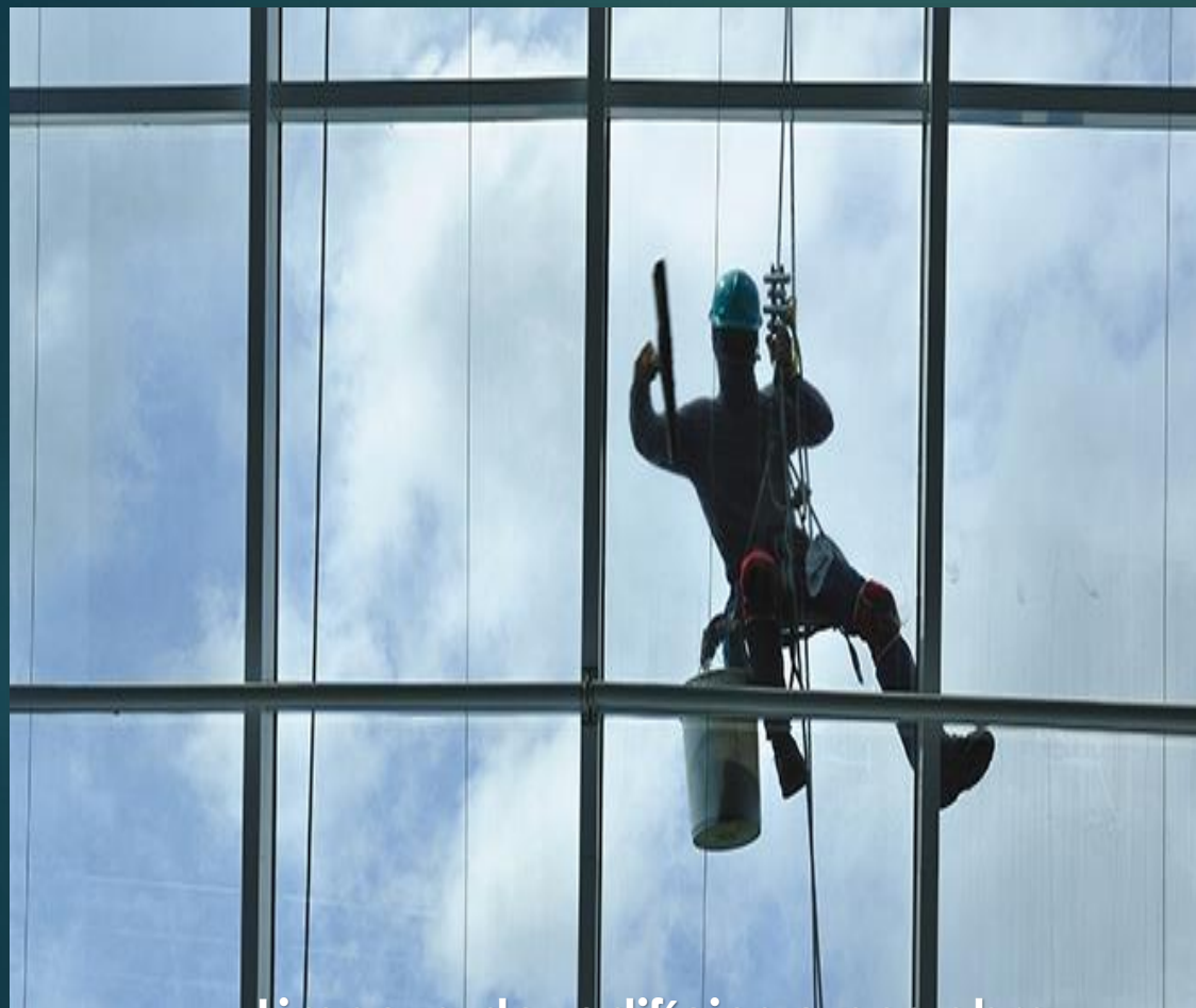
Limpeza de edifícios e pos obra
