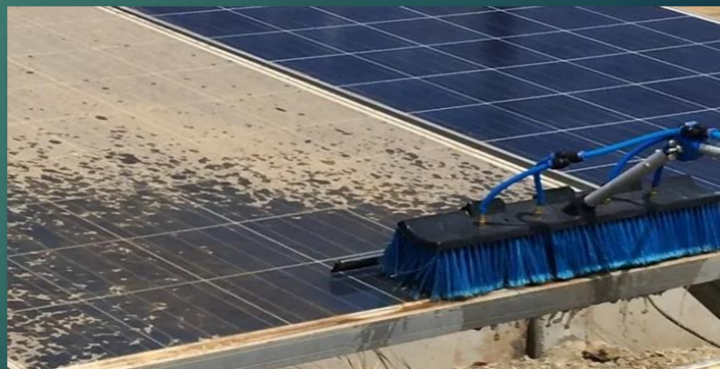
Limpeza de painéis solares
