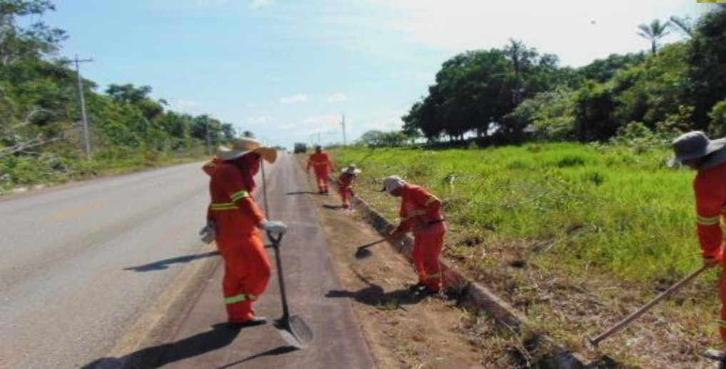
Limpeza de drenagens e desassoreamento de correços
