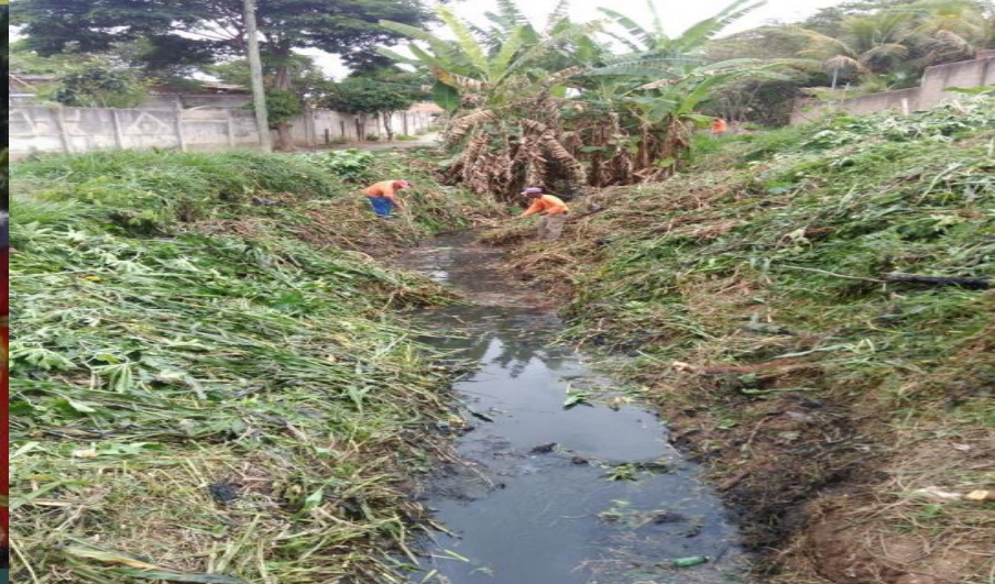
Limpeza de drenagens e desassoreamento de correços
